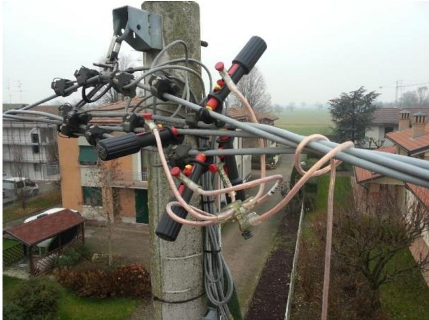
**Foto 1:** esempio di messa a terra e in cortocircuito di tutti i conduttori compreso il neutro realizzata sul sostegno dove si lavora.
